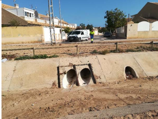
Imagen 5. Pozo Sifón en la intersección de Calle la Albufera con Calle Las Rocas.
