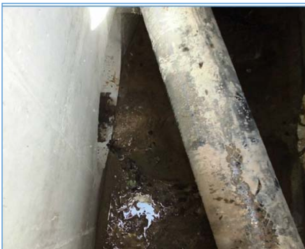
Detalle infiltración por las juntas en arquetas.
