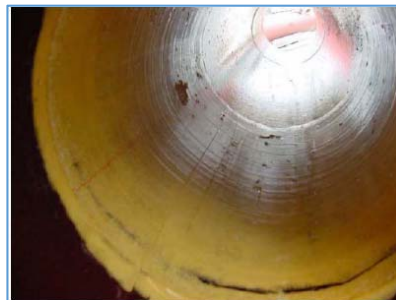
Foto 9.-Imágenes del colector reparado con el sistema packer
