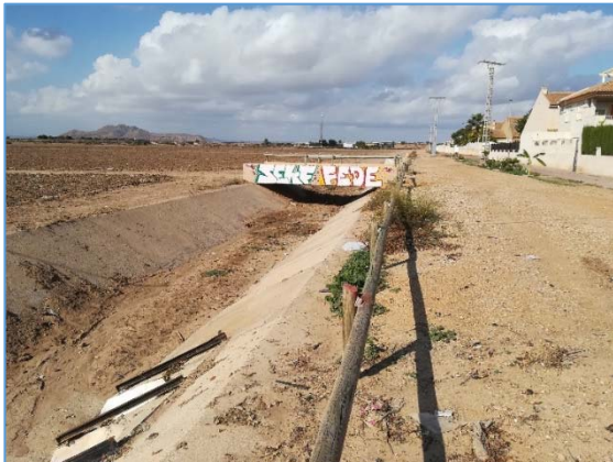
Foto 1.- Canal de pluviales que recoge la escorrentía de la Rambla de la Maraña y Torre Pacheco.
