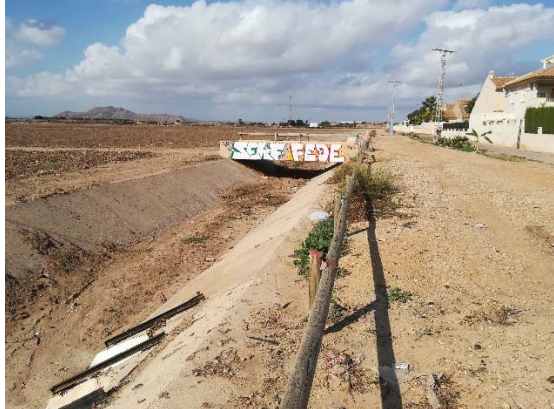
Imagen 3. Vista de las tomas de Pluviales formado por dos tubos de PVC DN 1000 mm. Calle Labrador con Calle la Albufera
