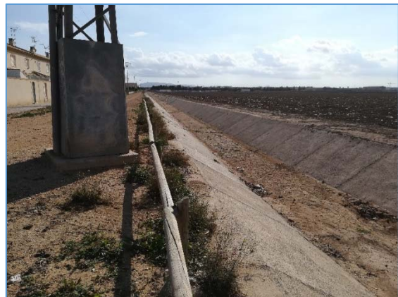
Foto 1.- Canal de pluviales que recoge la escorrentía de la Rambla de la Maraña y Torre Pacheco.
