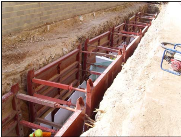
Sistema de entibación tipo Gi-P o similar para profundidades hasta 5.00 metros.
