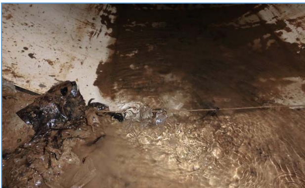
Detalle infiltración por las juntas de los colectores de PVC del Colector Dorada 1.
