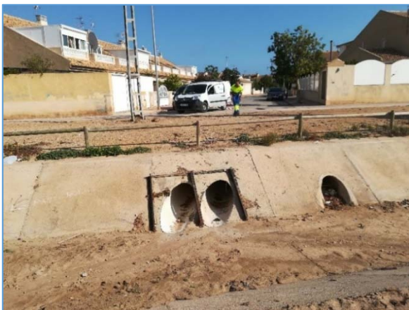
Foto 2.- Conductos de entrada del Canal
